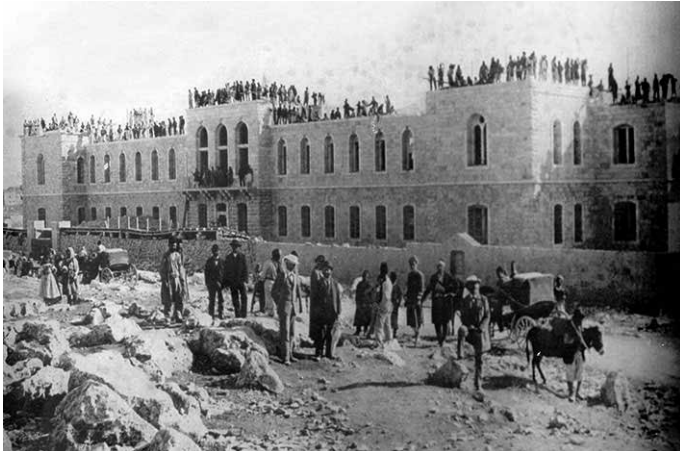
Construction de l'hôpital, rue Jaffa, Jérusalem, 1901. D. R.
