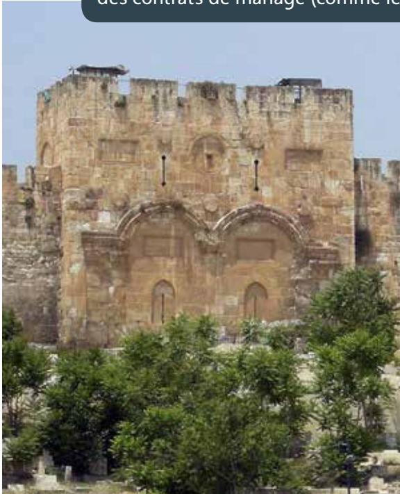
Porte dorée ou Porte de la Miséricorde. Porte située sur la façade orientale de l'enceinte de Soliman. Un décor du XVI e siècle surmonte le double arc antique. Wilson44691, 2009, PDA
