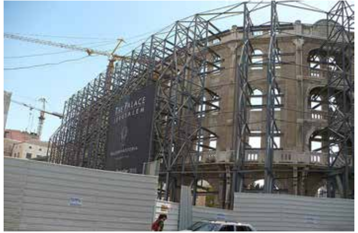
Palace en construction. Le bâtiment d'origine date de 1929. Yaffa CC BY-SA 2.0
